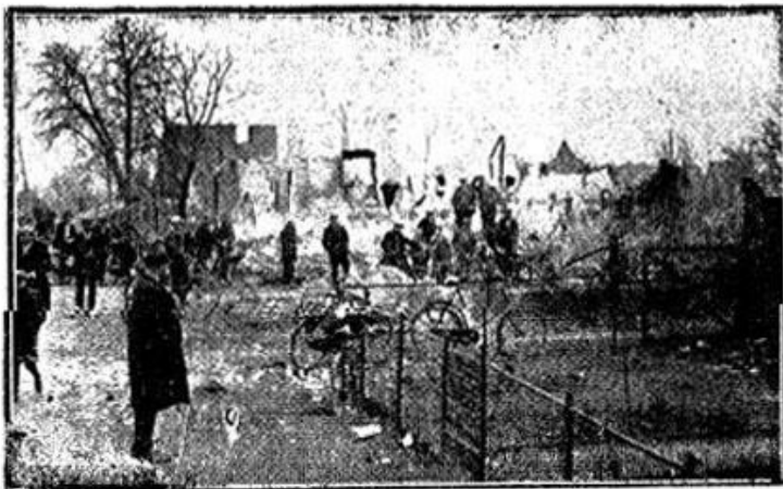
Een kiek op den hoek van de Dorpsstraat. — Wat er overbleef van de Amstelbierbottelaarij der firma Broeders. Alleen de muren van den winkel stonden nog overeind.
